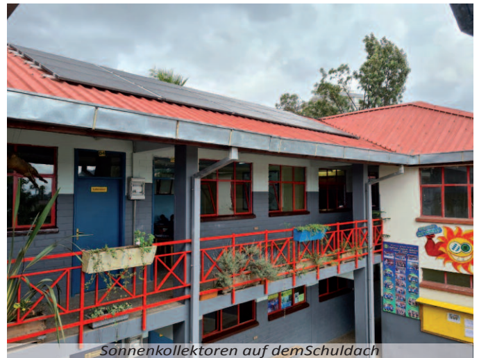
Sonnenkollektoren auf dem Schuldach
