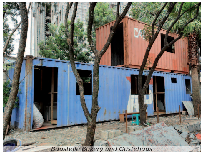
Baustelle Bakery und Gästehaus
